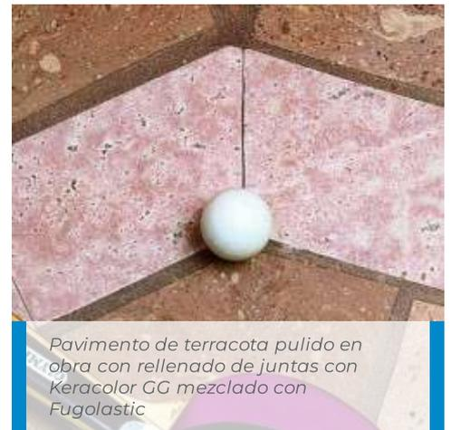
Pavimento de terracota pulido en obra con rellenado de juntas con Keracolor GG mezclado con Fugolastic.
