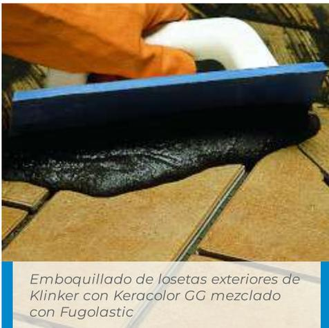
Emboquillado de losetas exteriores de Klinker con Keracolor GG mezclado con Fugolastic.
