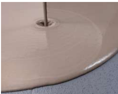
Aplicación de enlucido autonivelante sobre Eco Prim Grip Plus seco y aplicado sobre viejo pavimento
