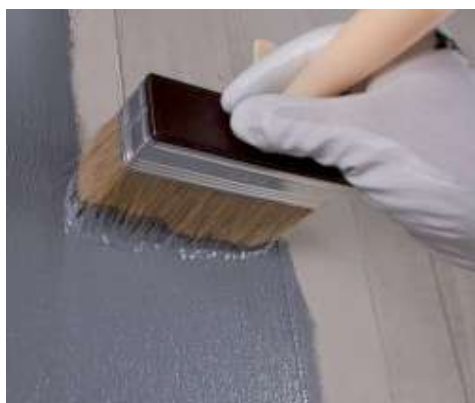
Aplicación de Eco Prim Grip Plus con brocha sobre soporte de hormigón
