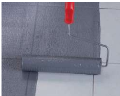
Aplicación a rodillo de Eco Prim Grip Plus sobre pavimento existente de losetas de gres porcelánico
