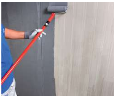
Aplicación de Eco Prim Grip Plus a rodillo sobre soporte de hormigón
