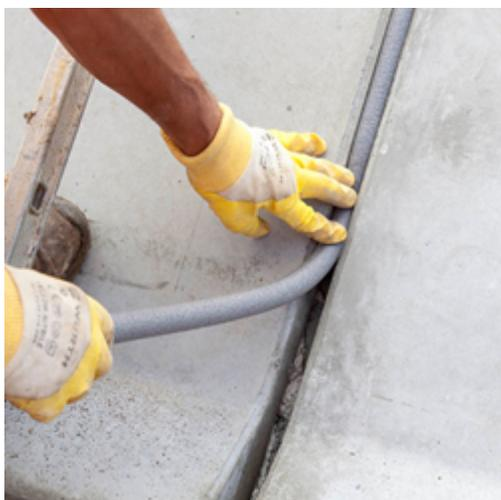
Colocación de Mapefoam M en junta flexible de una terraza.
