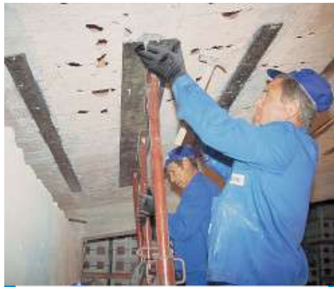
Puesta en obra de placa metálica para refuerzo estructural
