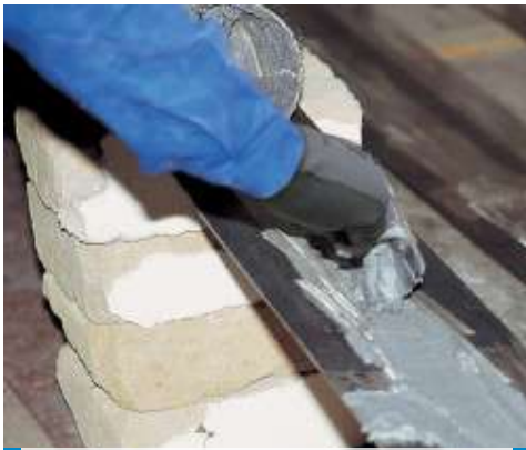
Aplicación de Adesilex PG1 sobre placa metálica
