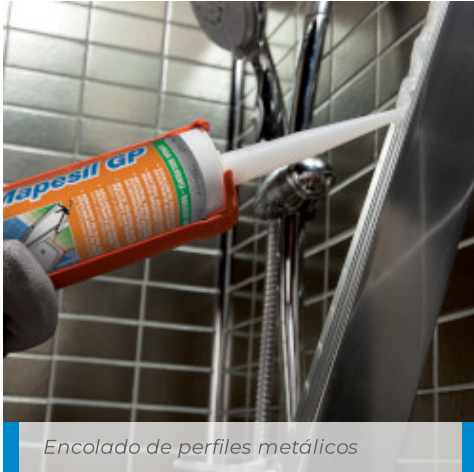
Sellado de la conexión entre diferentes materiales
